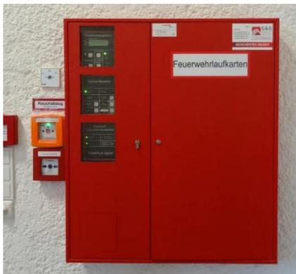
Zu den technischen Einrichtungen gehören u. a. Brandmelde- oder Brandwarnanlagen, Brandschutztüren, Löschanlagen, Fluchtwegkennzeichnungen, Rauch- und Brandmelder und tragbare Feuerlöscher.
